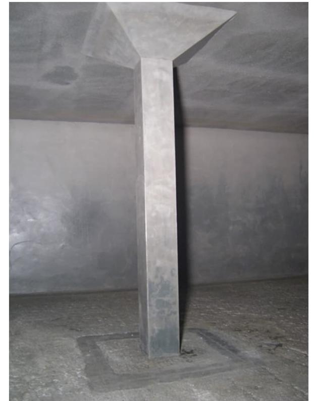
Erfolgte Beschichtung Wand + Stütze
