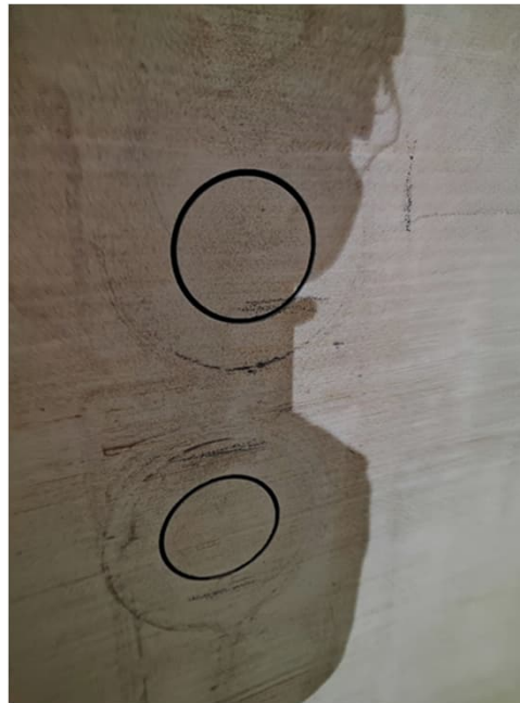
Kernbohrungen Ø100mm
