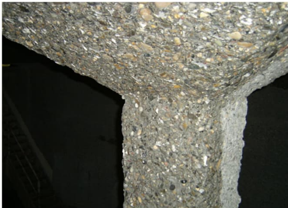
Stütze nach Abtrag
